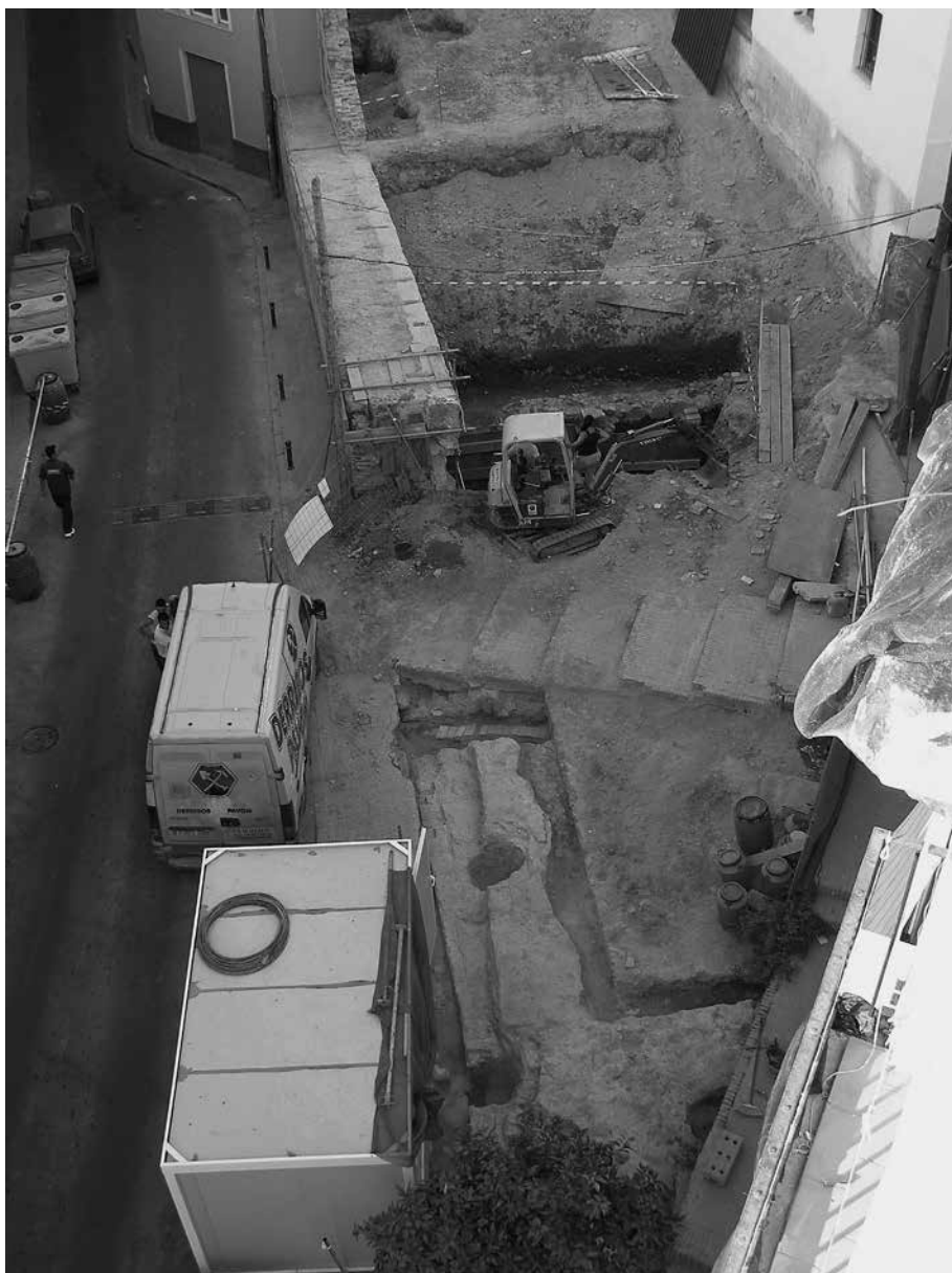
Fig. 3. Tramo de muralla y torre en la línea de fachada a calle Goles.
